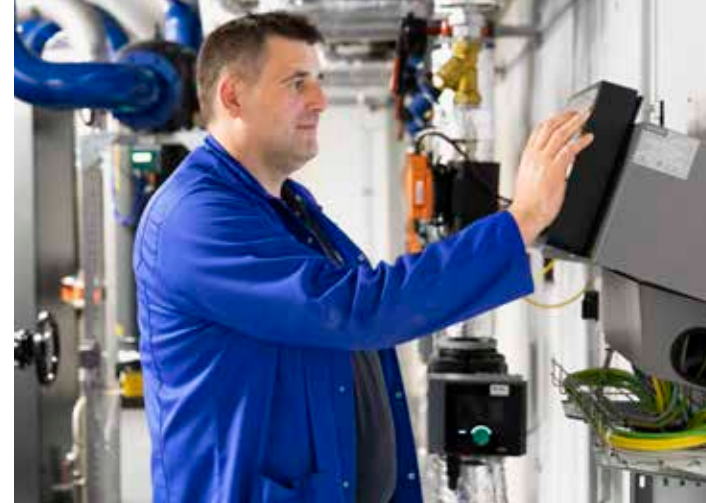
A SIGMA AIR MANAGER 4.0 a sűrített levegő szükségletehez igazodó kezeléssel gondoskodik az egyes kompresszorok lehető legjobb kihasználtságáról és az állomás egészének lehető leghatékonyabb működéséről.
